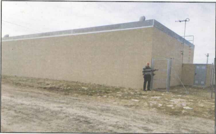
Josep Llobet, al costat del nou dipòsit construït al terme de Ferran
