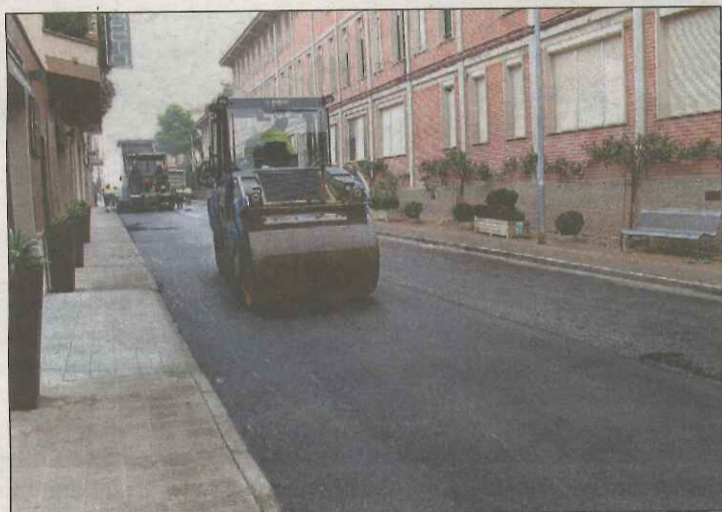
FOTO: Aj. de Tàrrega / Els operaris realitzen les obres de millora
